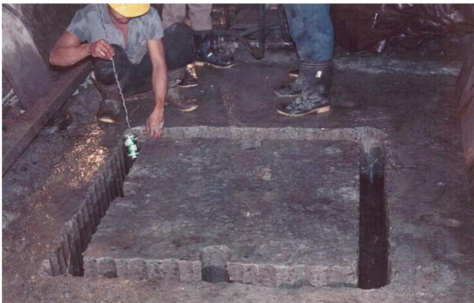
Abb. 3 Herstellung des Probekörpers durch Loch-an-Loch-Bohrungen
